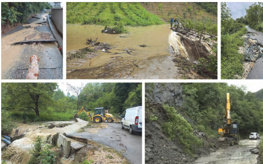
Slika 7. Poplave i klizišta na lokalnim putevima u okolini Aleksandrovcva i Kraljeva, jun 2023.
