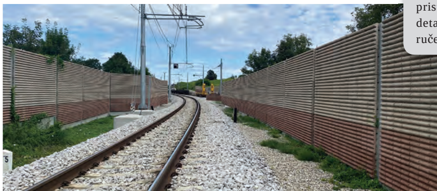
Betonski/drveno betonski PHONOBLOC® paneli za železnice (barijera protiv buke) na železničkoj pruzi Šentilj-Pesnica. Izvedeno 8 km i 24.000 m² panela. Investitor: DRSI.
