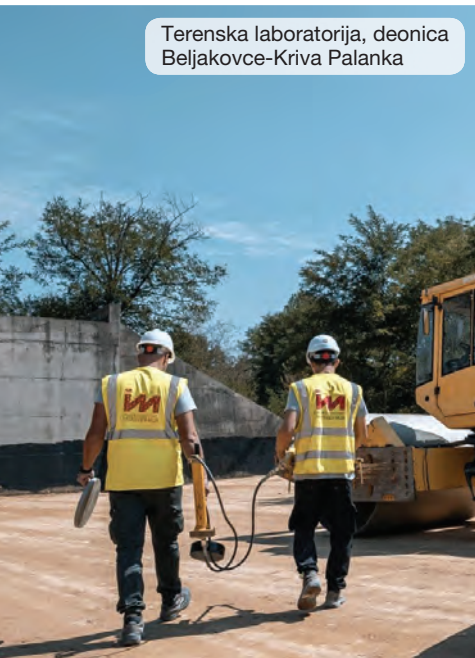
Remont dovodno-odvodnog tunela (DOT) RHE Bajina Bašta, Srbija
