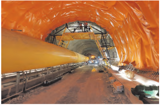
Hidroizolacija
