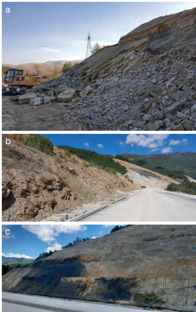
Slika 3. Prikaz nekih nestabilnosti kod različitih objekata i različitih geoloških sredina: a) Tipičan slučaj ravnog loma uzduž ravni slojevitosti za usek u Eocenskom flišu na ekspresnom putu Štip-Radoviš; b) i c) Različiti načini pojave lokalnih nestabilnosti i erozije na usecima duž trase auto-puta Kičevo-Ohrid, izvedenih u škriljastom metamorfnom kompleksu
