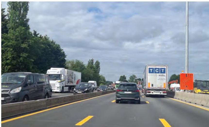
„Nevidljivo“ kontinuirano praćenje saobraćaja sa „pregradama za pametnu radnu zonu“ koje osećaju tok saobraćaja u oba smera pomoću DAS tehnologije
