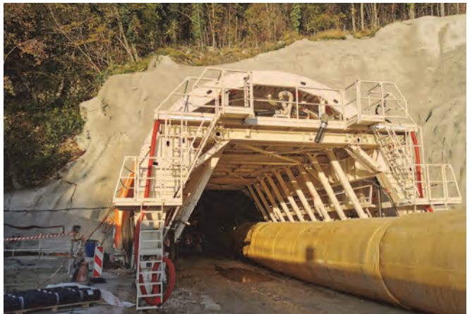
Oplata glavne tunelske cevi
