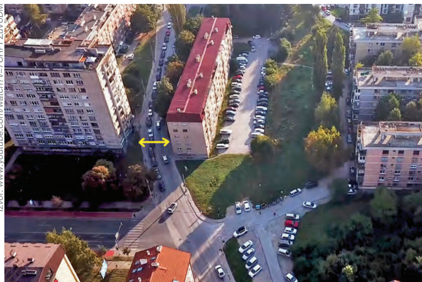
Slika 3. Fotografija predmetne raskrsnice
