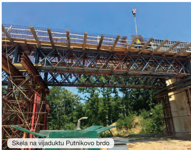
Slika 5. Oplata rasponske konstrukcije
