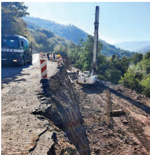
Radovi na prvom dijelu dionice
