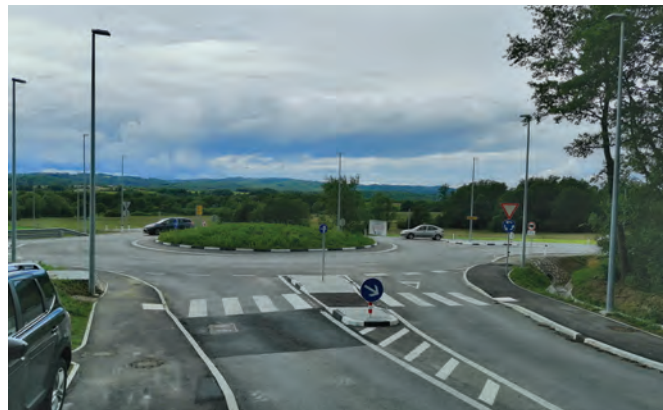
Kružna raskrznica van naselja kroz koju bi se moglo (teoretski) kretati brzinom od 90 km/h. Pasivno bezbedni stubovi visoke apsorpcije energije su itekako korisni.
