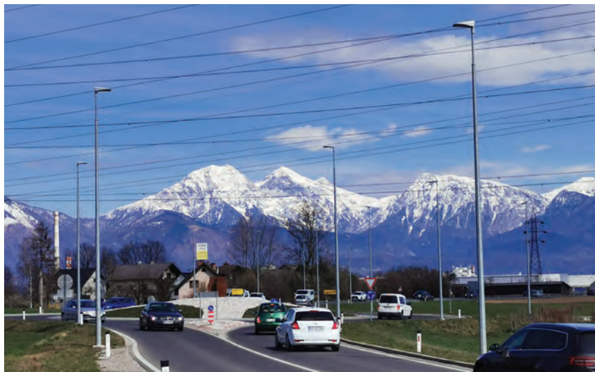
Još jedna kružna raskrznica opremljena pasivno bezbednim stubovima visoke apsorpcije energije u području brzine 50 km/h.
