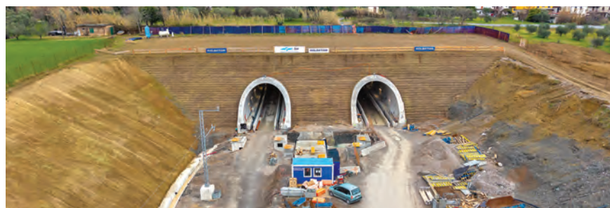
Tri najduža tunela na trasi se grade sa servisnim cevima
