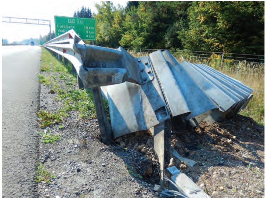
Početna konstrukcija koja pruža tek mali otpor udaru vozila. Tek ga je stubić odbojne ograde preusmerio preko čitave širine auto-puta što sigurno nije poželjeno funkcionisanje.
