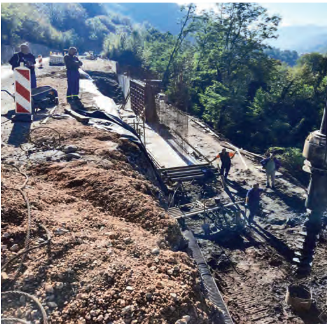
Radovi na prvom dijelu dionice
