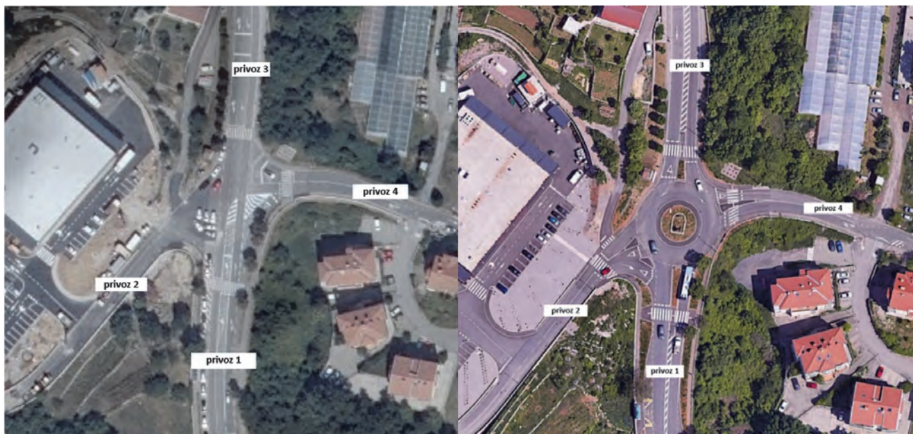
Slika 1. Primjer odabranog raskrižja za analizu: prije rekonstrukcije - klasično nesemaforizirano (lijeva slika) i nakon rekonstrukcije - kružno raskrižje (desna slika)
