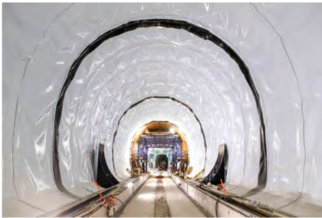
Hidroizolacija tunela
