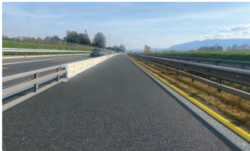
Privremene ograde za gradilišta na auto-putu A2 Kranj-Jesenice. Izvedeno 13 km privremenih ograda kombinacije betonske ograde DELTABLOC SB 50 i čelične ograde DELTABLOC STEEL PRO 500. Investitor: DARS d.d.
