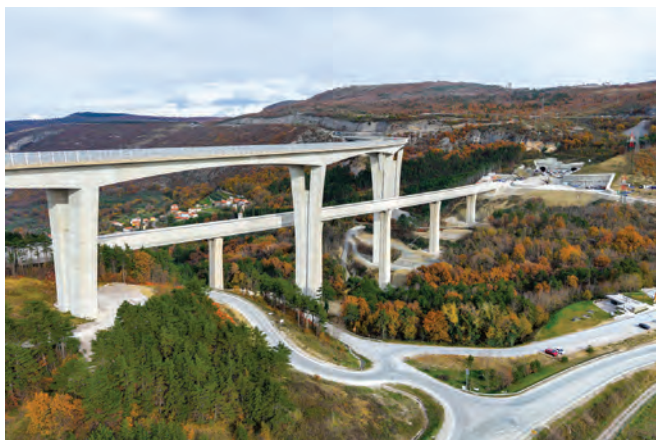
Vijadukt Gabrovica prolazi ispod vijadukta auto-puta Črni Kal
