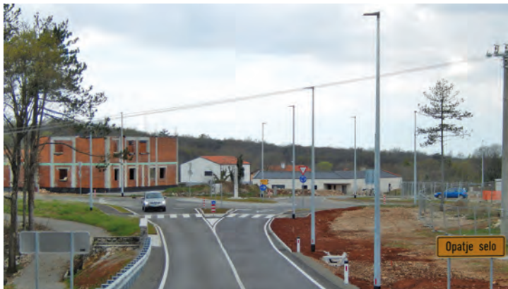
Projektant je pravilno odlučio da se upotrebe pasivno bezbedni stubovi visoke apsorpcije energije jer se kroz kružnu raskrnicu može voziti brzinom od 50 km/h.
